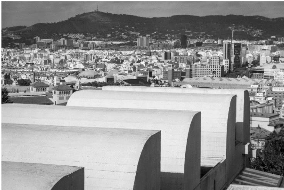
Detail of the skylights of the Fundació Joan Miró building © Fundació Joan Miró, 2016. Photo: Pep Herrero
