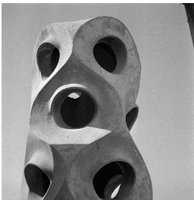
Joaquim Gomis. Detail of one of the chimneys on the roof terrace of La Pedrera. Joaquim Gomis Archive, held by the Arxiu Nacional de Catalunya - © Heirs of Joaquim Gomis. Fundació Joan Miró, Barcelona.
